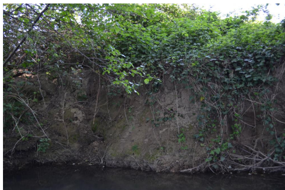
Erosion de berges de 1 à 1,5 m de hauteur.
