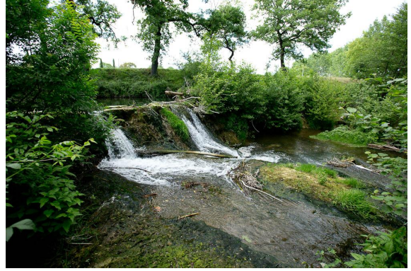
Seuil en amont.
