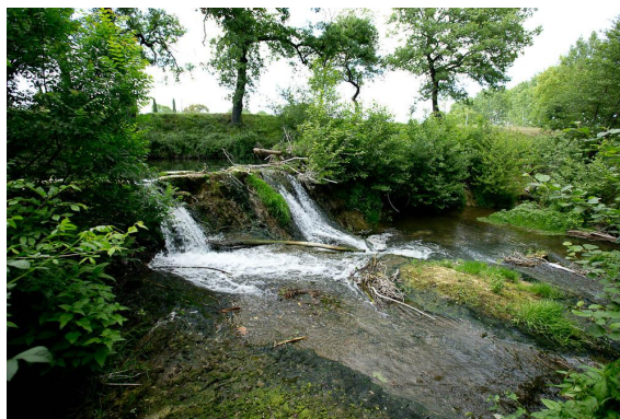
Seuil en amont.
