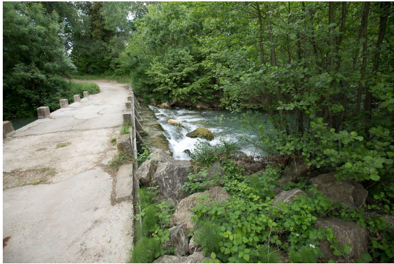
Ripisylve des Seynes au niveau du seuil.
