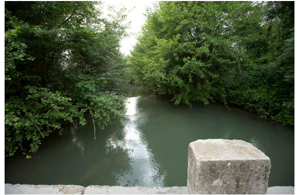
Ripisylve des Seynes au niveau du seuil.
