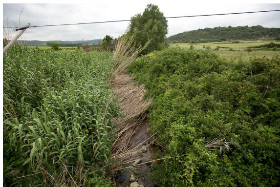
Vue du pont amont : les Cannes de Provence illustrent le mauvais état des berges.
