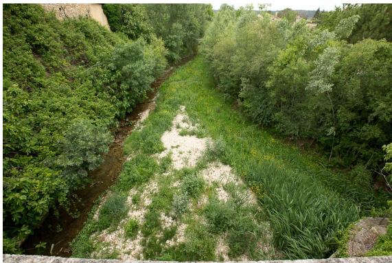
La rivière a été entretenue par le SMAGE : densification de la ripisylve, les atterrissements se végétalisent peu à peu.
