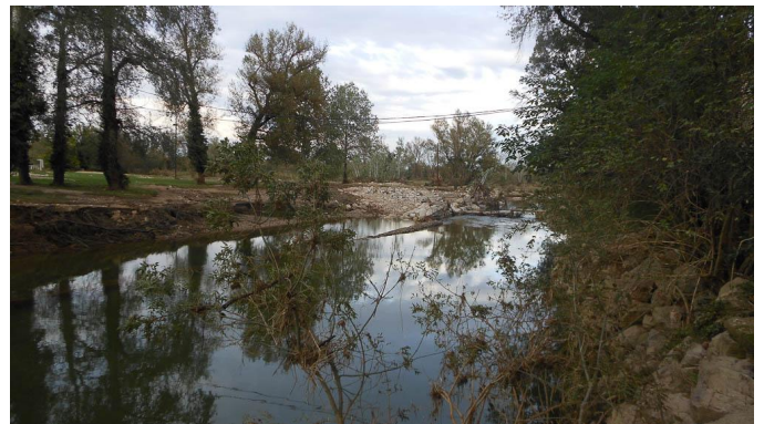
Après la crue d'octobre, la rive gauche a été fortement érodée.
