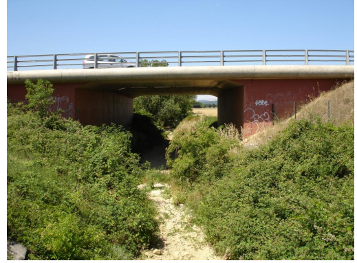
Passage sous la N106.
