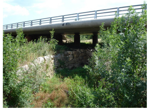
Au niveau du pont de la N106.
