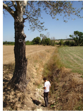
Ruisseau temporaire canalisé et très incisé avec des berges abruptes et sans ripisylve en aval de le Vignal.
