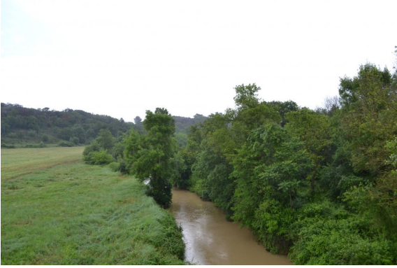
Aperçu de l'Avène depuis le viaduc du chemin de Trespeaux.
