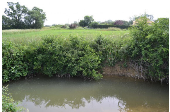
Secteur de berges érodées sur le Vallat d'Arias.
