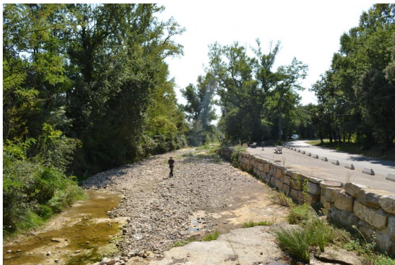
En aval de Pont Noyé.
