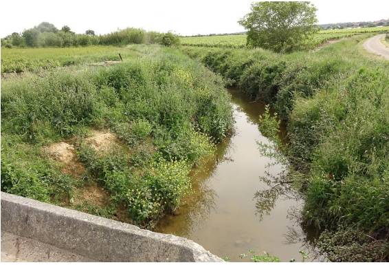
Aspect très dégradé des berges très incisées du Rieu.
