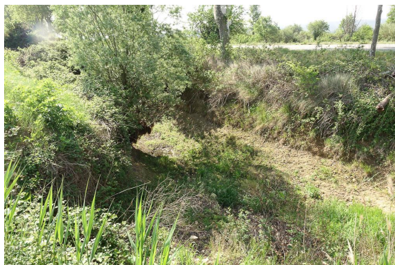
Vue générale depuis le haut.
