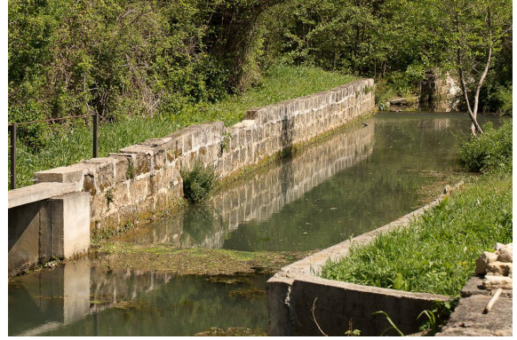
Un système hydraulique maintient un niveau d'eau supérieur (> 2m) en amont).
