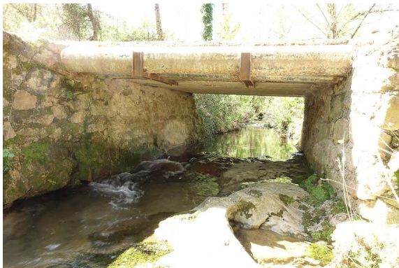
Pont donnant accès à une maison.
