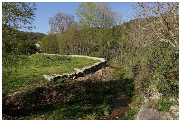
Enrochement récent juste en amont de la route de Saint-Jean-du-Gard.
