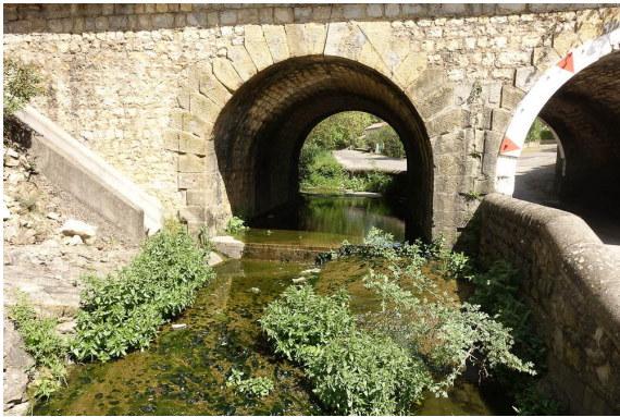
Vue du pont de la voie ferrée en aval.
