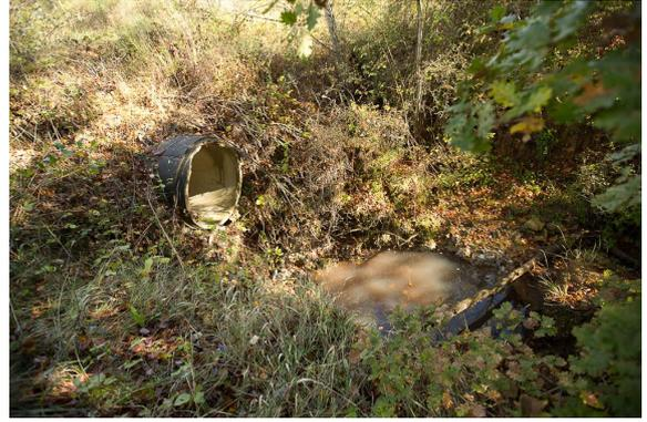
Une buse passe sous le chemin d'exploitation de la carrière, avec une érosion en aval.
