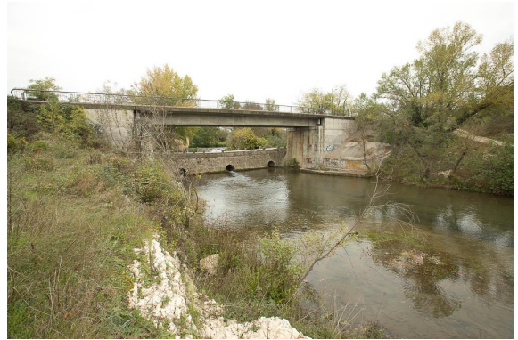
La pont de la D3 sur l'Alzon.
