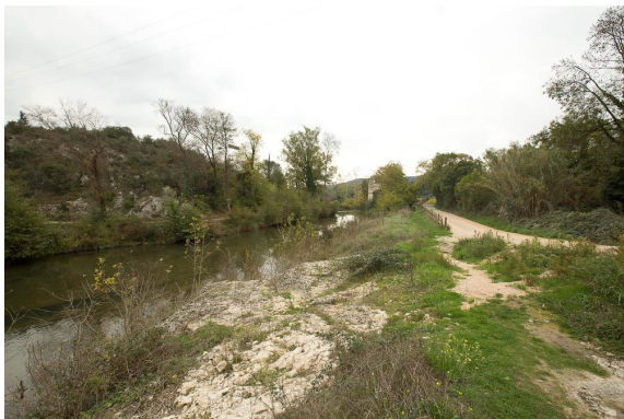
L'Alzon en aval du pont de la D3 : ripisylve très dégradée !
