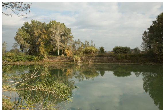
Vue générale depuis la rive droite du Gardon. On remarque une grande zone d'érosion dans la berge en rive gauche.
