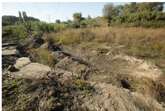
Zone de déblais derrière la berge abrupte du Gardon ; Canniers de Provence et ripisylve du Gardon.
