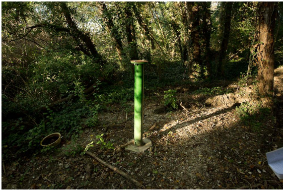
Un piézomètre a été installé.
