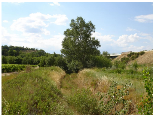
Ripisylve éparse sur cours d'eau reprofilé lors des travaux de la N106.
