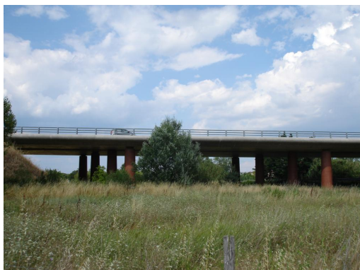
Pont franchissement de la N106 sur le ruisseau de l'Auriol.
