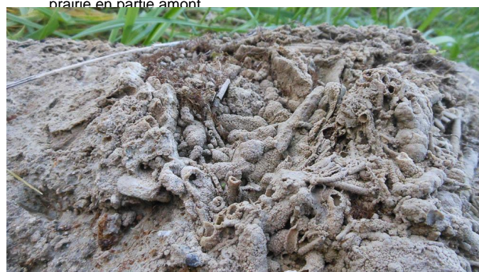
Tuf arraché par la crue d'octobre 2014.
